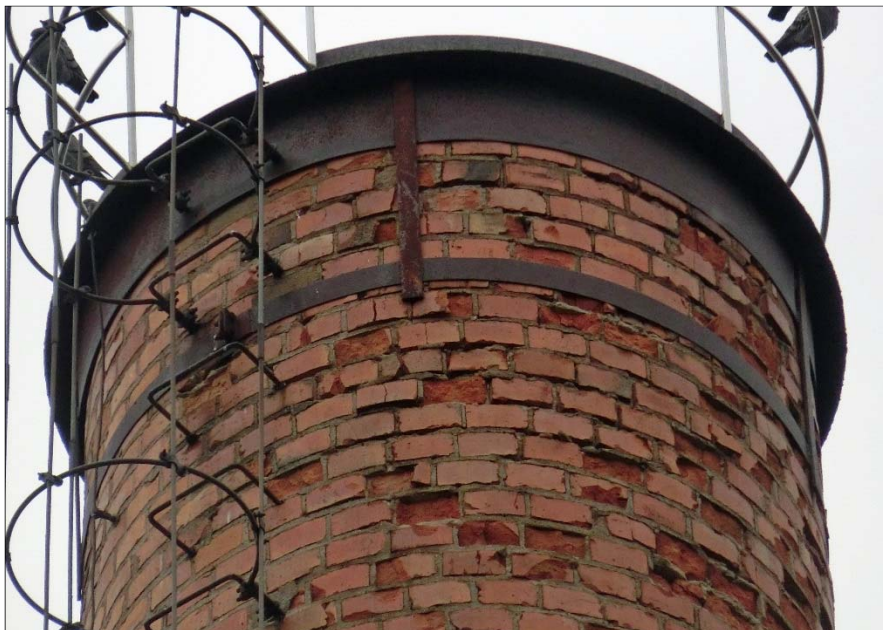
Skorstenens övre del, fotograferad med teleobjektiv.
