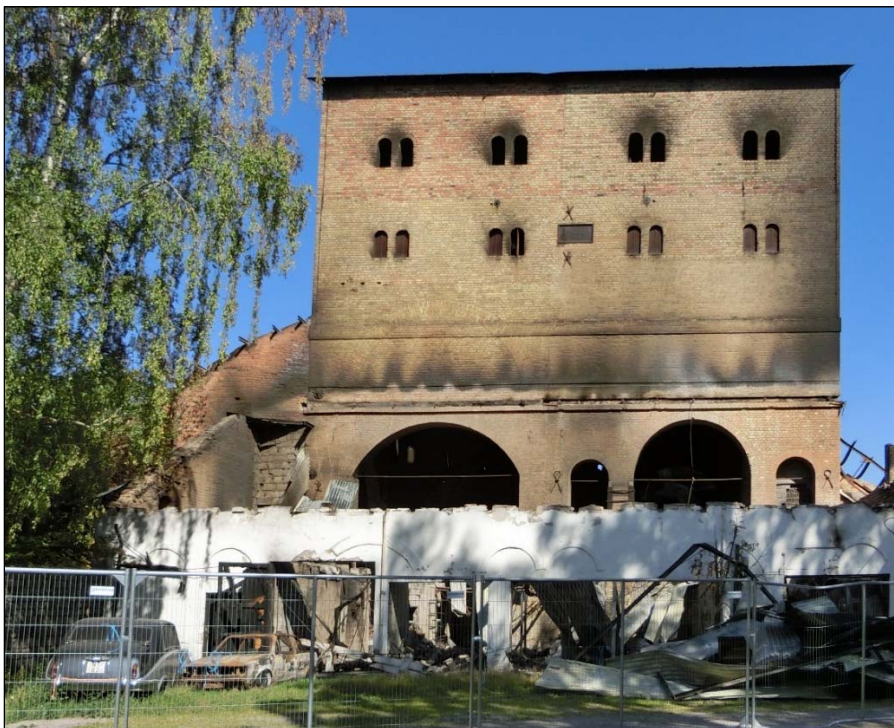
Masugnsbyggnadens södra långsida med rådstugans vitputsade fasad i förgrunden.
