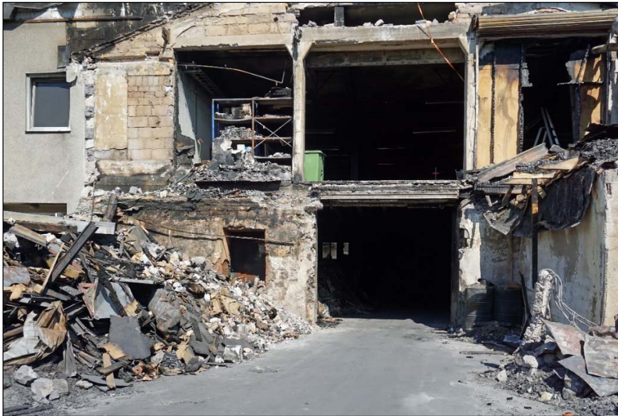
Anslutningen mellan den gamla och den nya f.d. radiofabriken. Bottenvåningens vägg tillhör den gamla radiofabriken och har väggar av slaggsten. Denna vägg, och tillhörande fönsteröppning med stödvalv, tillhör sannolikt den gamla krossverksbyggnadens norra gavel.
