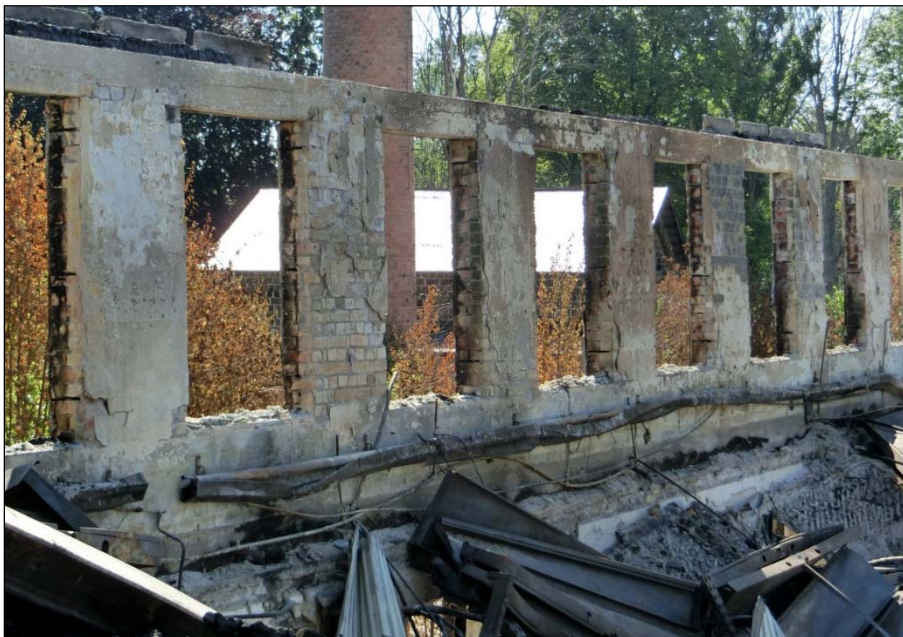
Tegelmur med fönsterrad mot Toboån.
