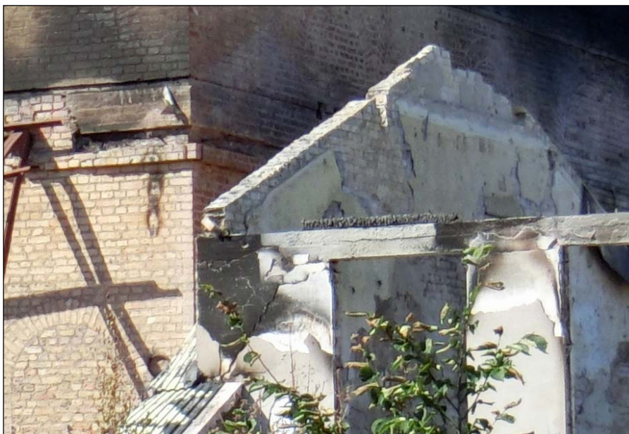
Radiofabrikens gavelröste mot masugnsbyggnaden. Röset är uppfört i enstens murverk av gult tegel.
