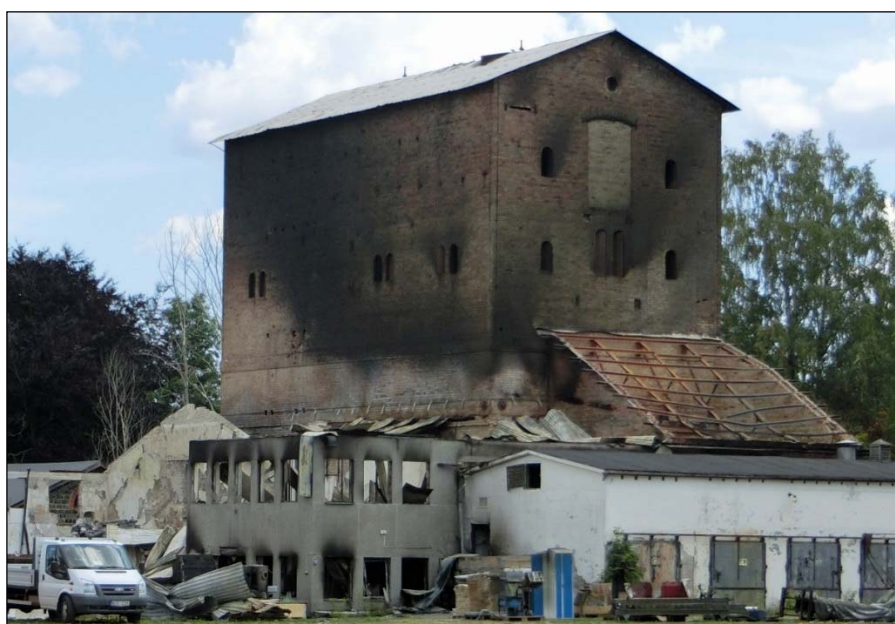
Masugnsbyggnaden från väster med ruin av radiofabriken, sekundär tillbyggnad mot gaveln utan yttertak samt torkugnsbyggnad med garageportar.
