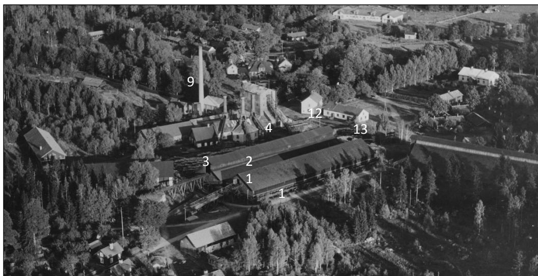
Hyttan 1930. Driften har nyligen lagts ner men byggnaderna, inklusive rostugnarna, tycks vara intakta. Byggnadsbeteckningar enligt karta ovan. TM.
