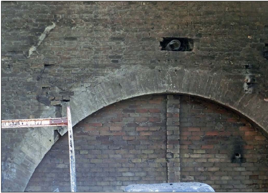
Igenmurad valvformad öppning mot krossverks- byggnaden.
