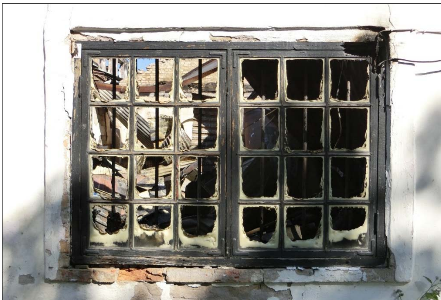
Fönster till maskinhuset. Fönstret har beslag som var populära under första hälften av 1900-talet och härrör sannolikt från ombyggnads- arbetena på 1910-talet. Fönstret hade då en rundbågig överluft.
