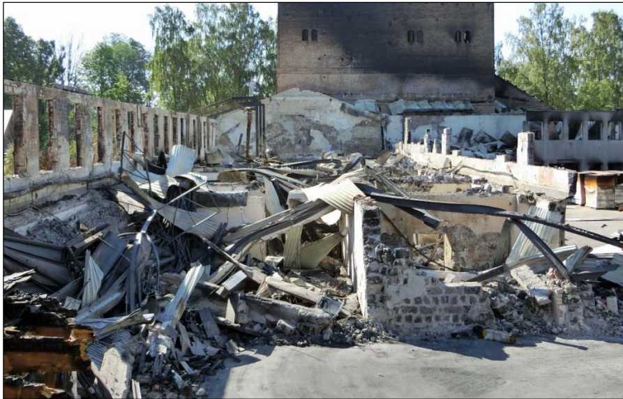
Byggnaden blev totalförstörd i branden. Mitt i bilden syns ett parti av putsat slaggstensmurverk som tolkas som en del av den gamla krossverksbyggnaden.
