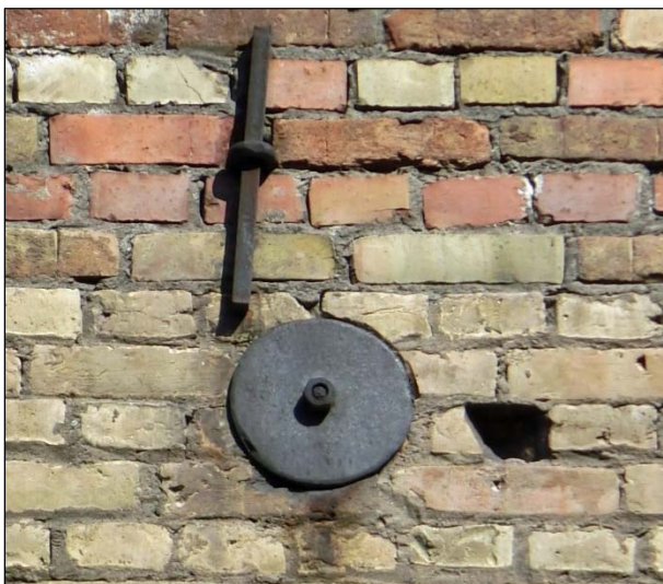
Masugnsbyggnadens hörn har förstärkningar i form av tallriksankarslut i gjutjärn.
