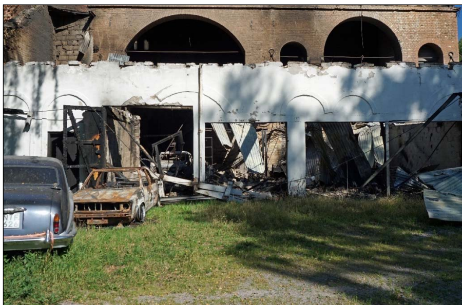
Den ursprungliga fasaden på södra långsidan är fortfarande avläsbar genom de markerade valvbågarna, som anger tidigare fönster- och dörröppningar.
