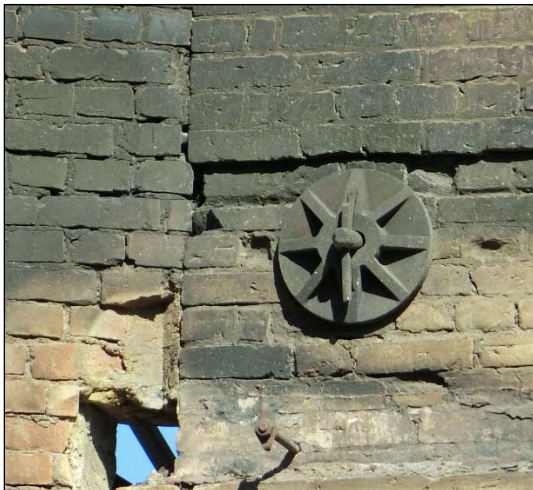
Masugnsbyggnadens hörn har förstärkningar i form av tallriksankarslut i gjutjärn.
